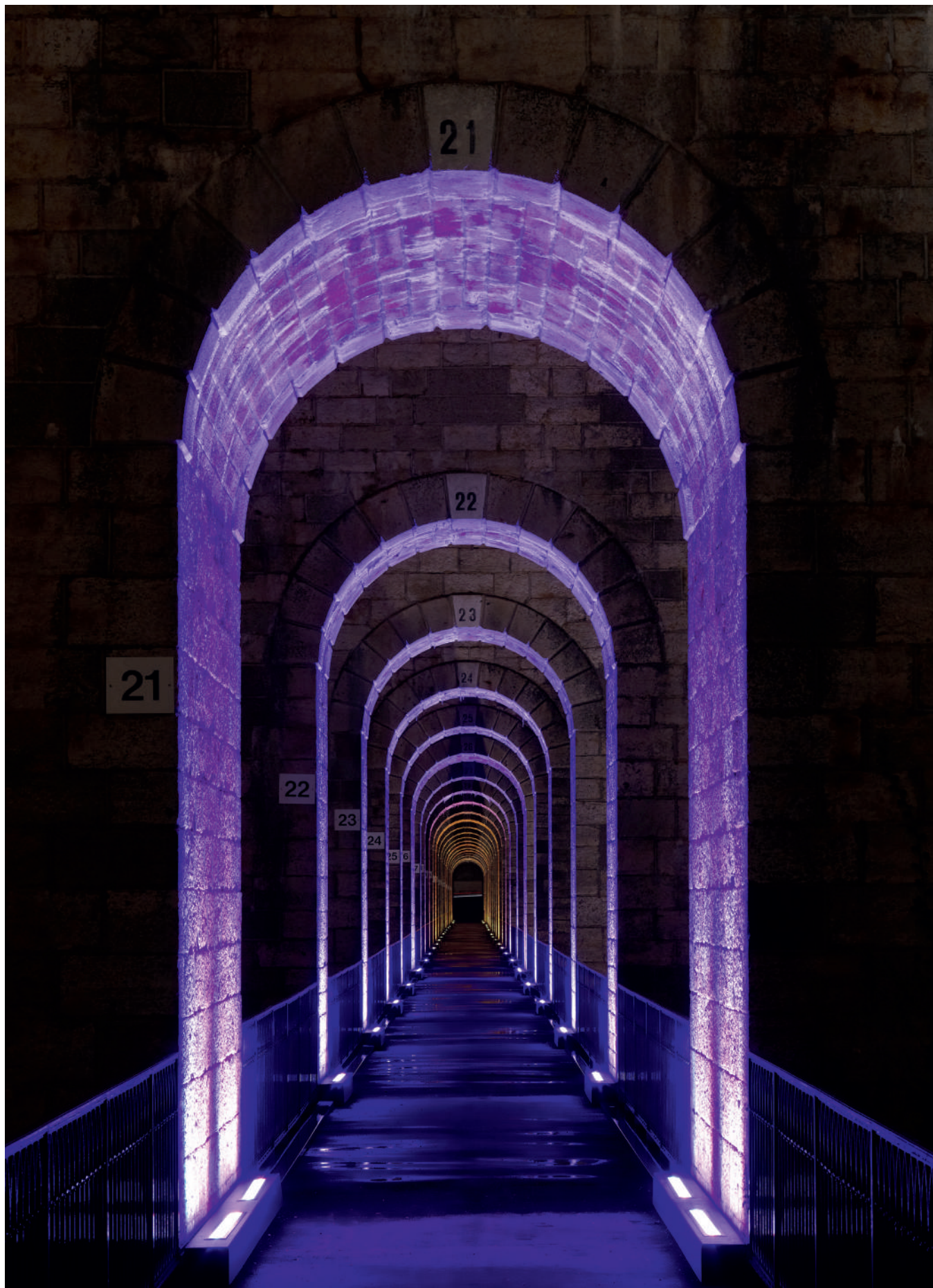
Chaumont Viaduct - France Ph: Richard Pelletier - Mairie de Chaumont
