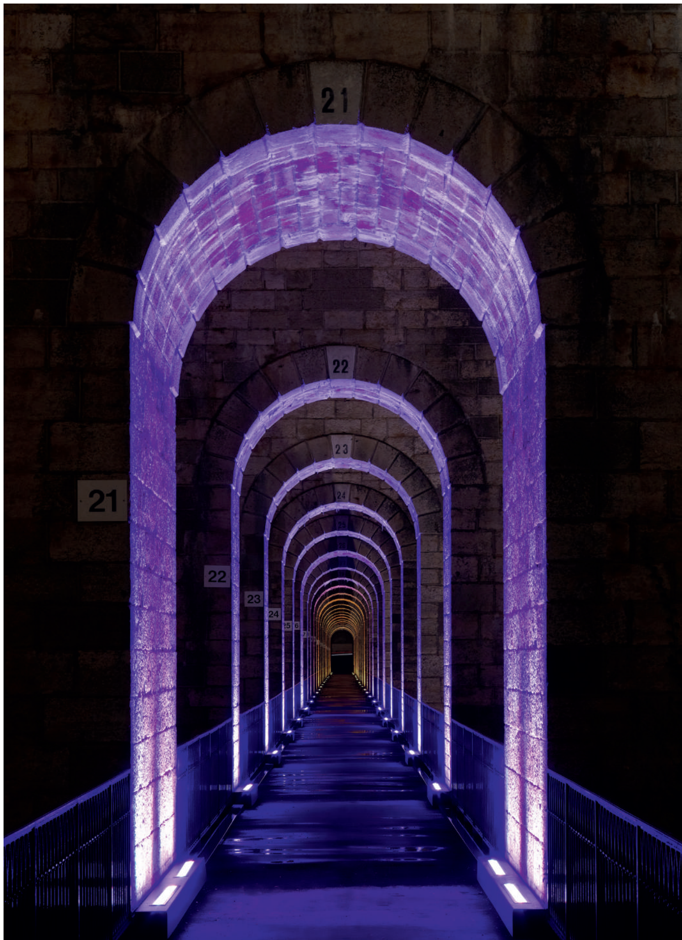
Viaduc de Chaumont - France Ph: Richard Pelletier - Mairie de Chaumont
